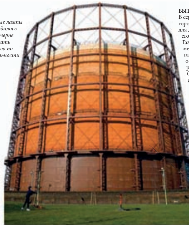
Газгольдеры опускались в землю по мере того, как внутри них снижался уровень газа
