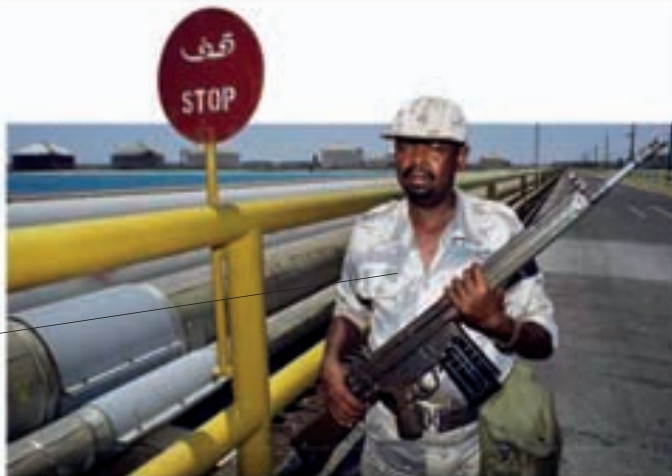
Охрана трубопровода в Саудовской Аравии
